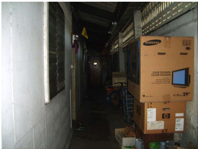
ที่พักคนงานครัว : มีขนาดคับแคบ ต้องกองเก็บของบริเวณทางเดิน เสี่ยงต่ออัคคีภัย
